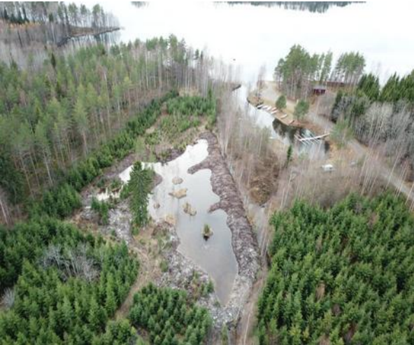
Sammakkolahden kosteikko, tila 167-409-19:35, kosteikkoala 0,25 ha. Vesi on ohjattu kosteikolle ja kosteikolta pois rumpuputkilla, 315 mm ja tulvapatki 400 mm.
